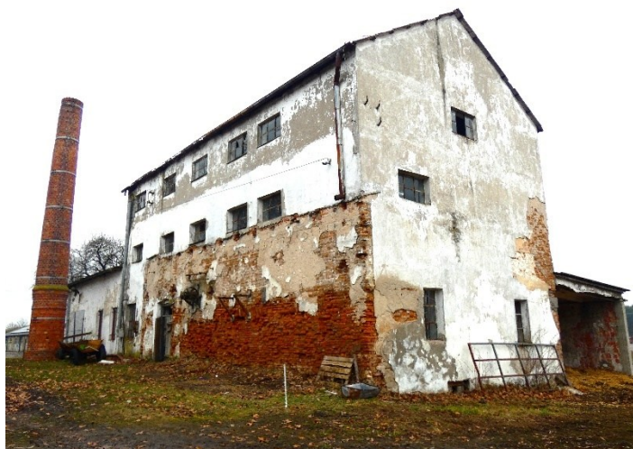
Fot. 13. Gorzelnia w Trynosach-Osiedlu
